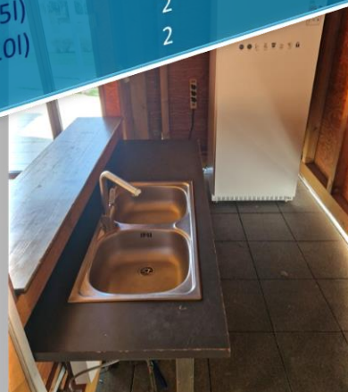
Doppelspülbecken mit Warmwasser
