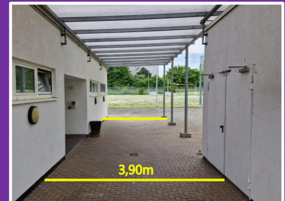
Überdachte Fläche / ca. 70m 2
