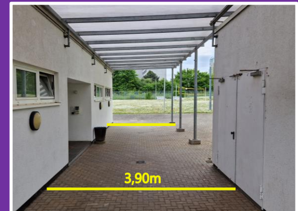
Überdachte Fläche / ca. 70m 2
