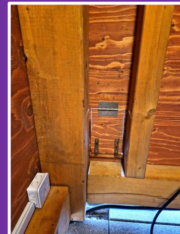
Klappe für Strom nach draußen
